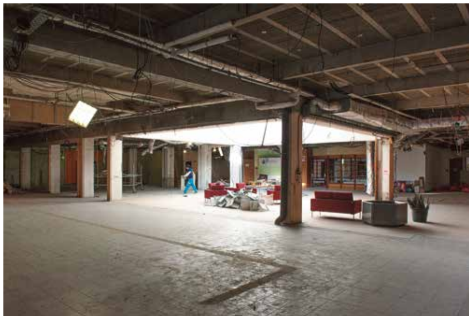
En ce moment, l'intérieur de la médiathèque est en plein chantier.
