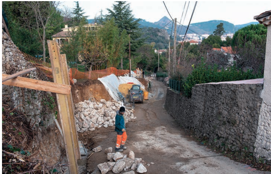
200 m 2 de mur de soutènement seront refaits à neuf en février sur le chemin de la Fontaine des Trois Gouttes.
