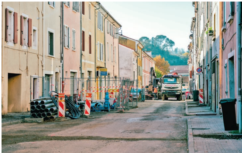
Le chantier de réfection des réseaux d'eau potable dans le quartier de Rochebelle aura nécessité 2 ans de lourds travaux et un investissement de 5 M€.
