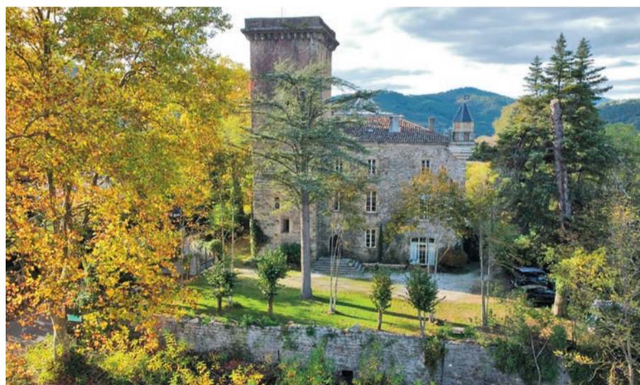
Les travaux de rénovation du château de La Fare, situé à Cendras, ont commencé en 2019.
