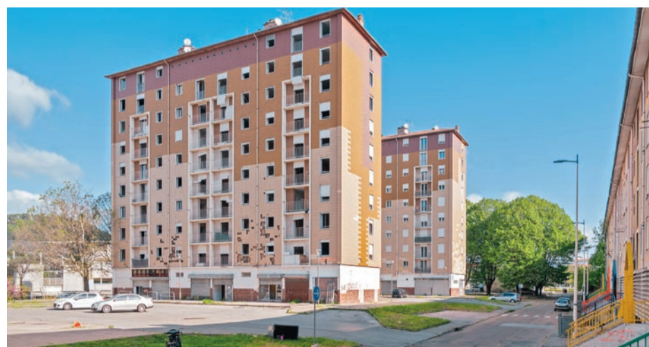
La tour n° 6/8 de la rue Sully Prudhomme sera la première à être démolie. Les travaux doivent débuter mi-février.
