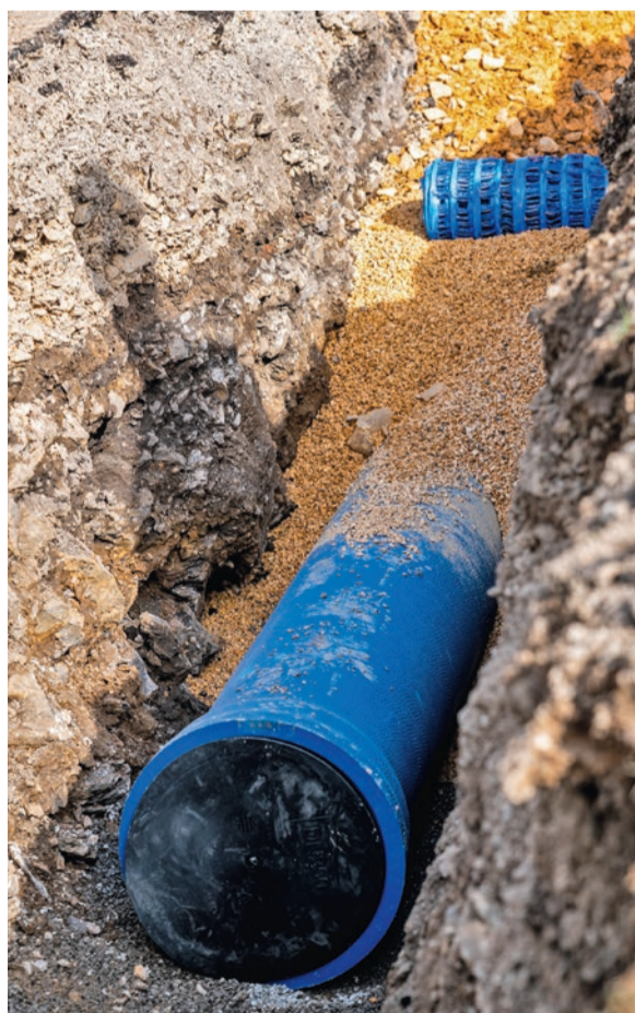
La distribution de l'eau potable, à Chamborigaud, est en cours de rénovation.
